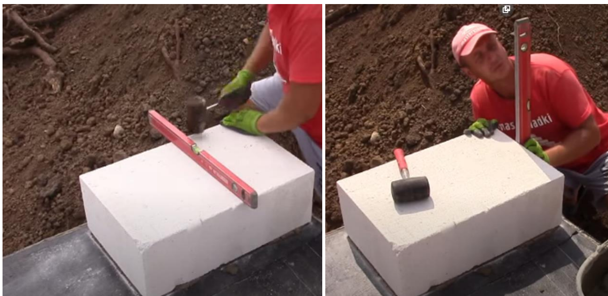
Рисунок 14 – Укладка блоков первого ряда
