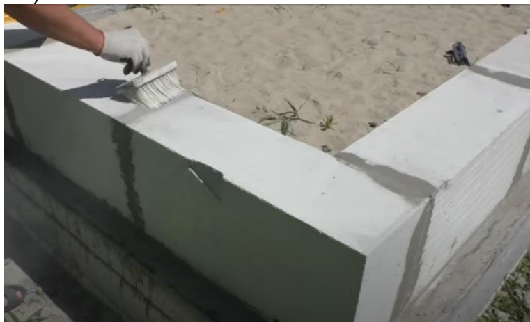
Рисунок 17 - Выравнивание неровностей и очистка поверхности
