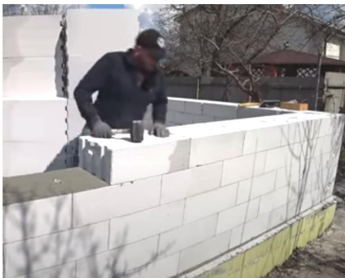
Рисунок 16 – Кладка стен из блоков с захватными карманами с перевязкой
