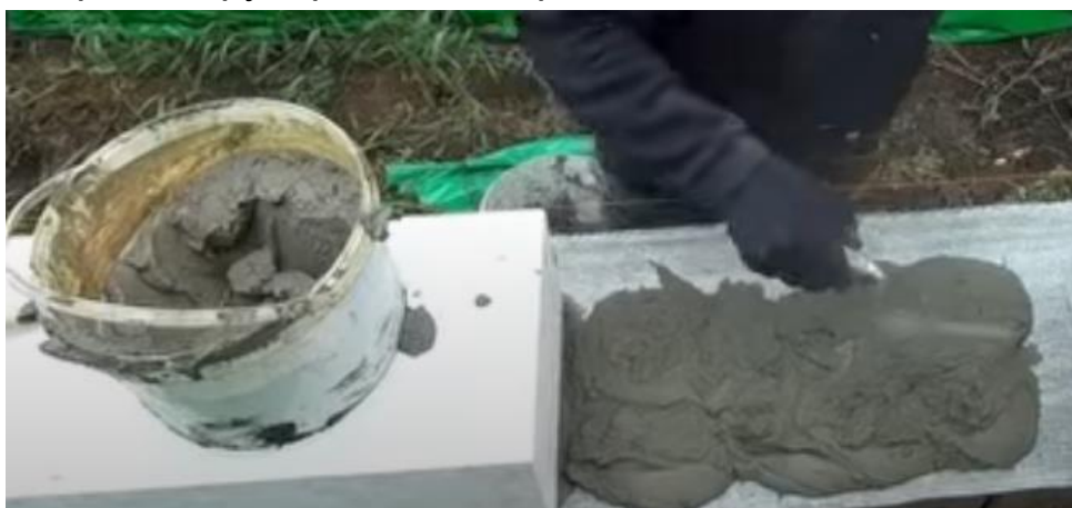
Рисунок 13 – Нанесение цементно-песчаного раствора по гидроизоляционному слою
