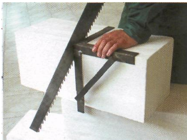
а) пилой – ножовкой по разметочному угольнику
