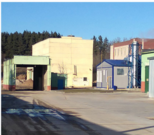
Здание ВЕСОВОЙ Ремонт 2018г.
