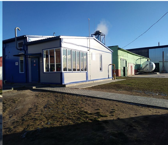
Здание БЛОЧНО-МОДУЛЬНОЙ КОТЕЛЬНОЙ 2018г.
