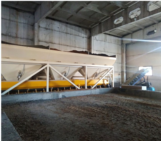
Бетонный завод ЛЕНТА-54 2019 г.
