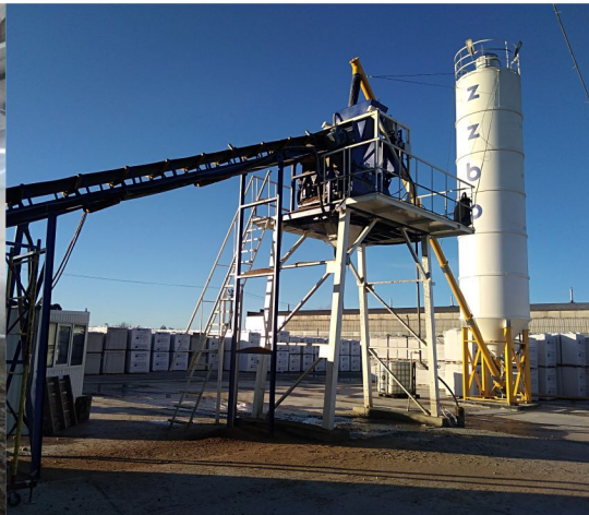
Бетонный завод ЛЕНТА-54 2019 г.
