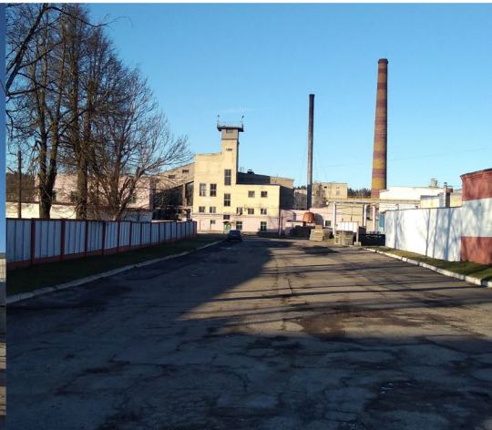
Здание КОТЕЛЬНОЙ Ремонт 2015г
